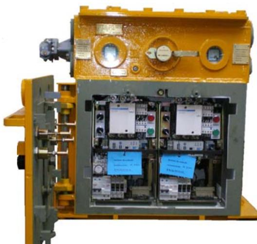
Detalle cofre KE32 Abierto con dos módulos contactor instalados.
