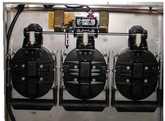
Detalle porta fusibles en el interior de la celda
