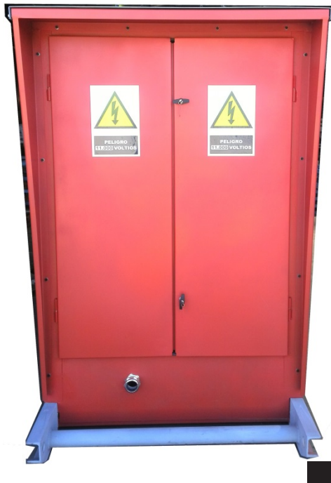
CELDA DE ENTRADA
